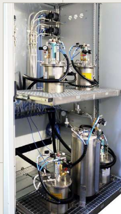
Armario de suministro de tinta con 4 depósitos de tinta y 1 de disolvente
